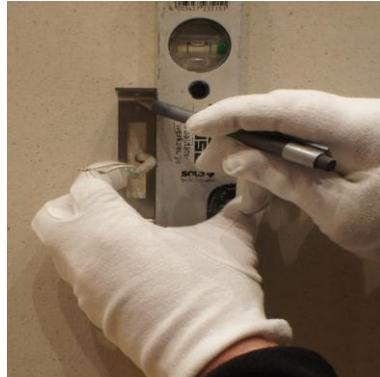
Schieben Sie den Befestigungsbügel über den Kabelauslass und markieren Sie die beiden Bohrlöcher. Achten Sie dabei darauf, dass die Bohrungen das Einspeisekabel nicht beschädigen werden. Achten Sie mit Hilfe einer Wasserwaage auf lotrechten Sitz der Bohrlöcher.
